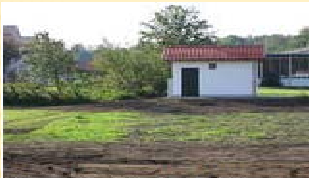
Drosselgebäude bei der Berufsschule
