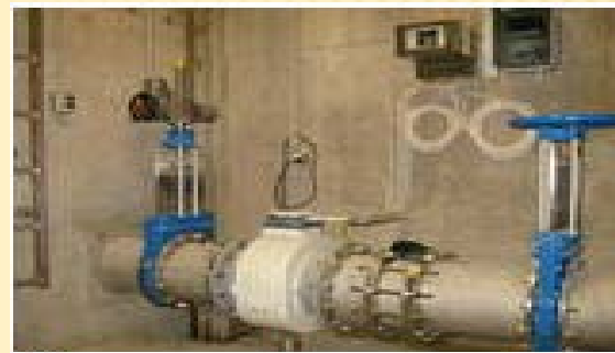
Steuerung der Abwassermenge über Elektroschieber und Messeinrichtung
